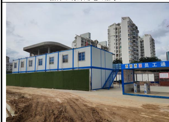
照片 5 在建太平金融产业港营地
