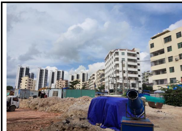
照片 1 在建项目施工营地现状
