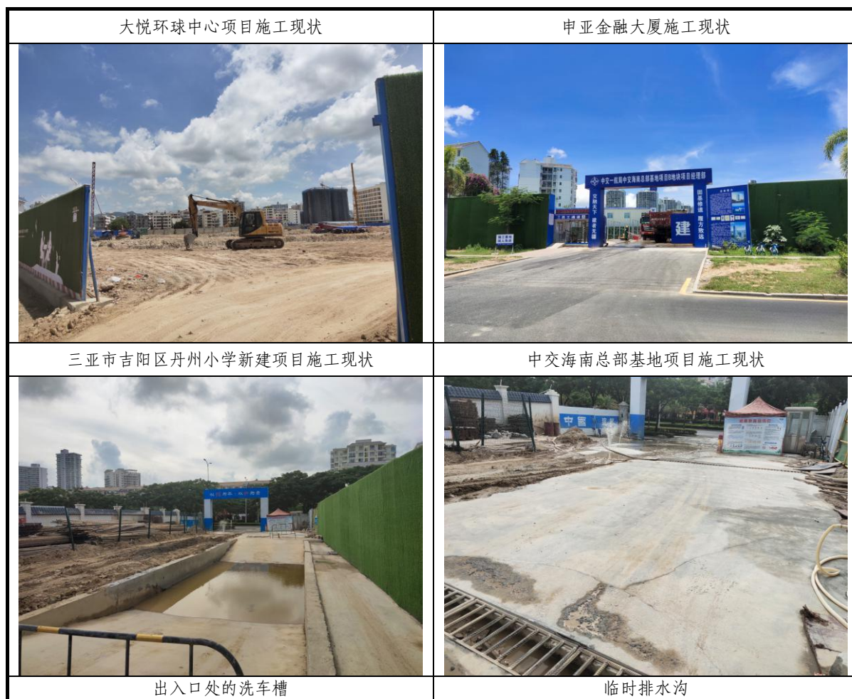
图 2-5 已入驻企业在建项目建设现状
