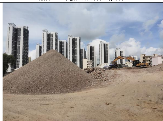
照片 6 拆迁建筑垃圾分拣、加工
