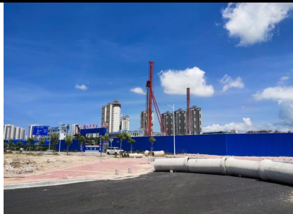
照片 2 在建管网工程
