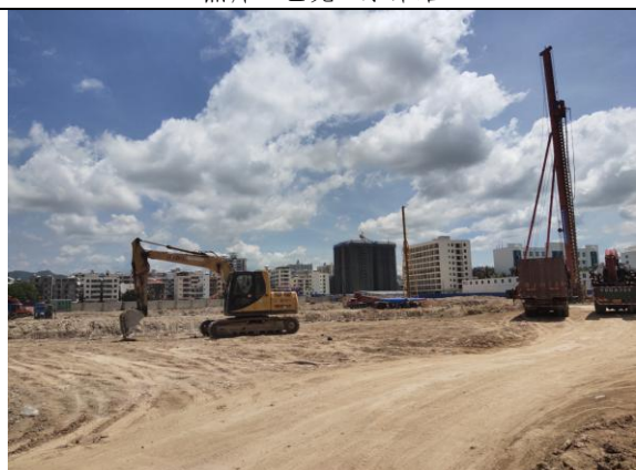
照片 6 在建丹州小学
