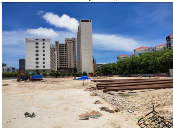
照片 8 申亚大厦项目现场（在建）
