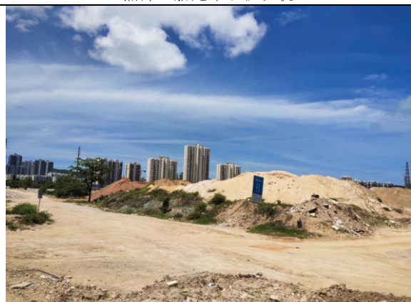
照片 7 项目建设区内的现状堆土
