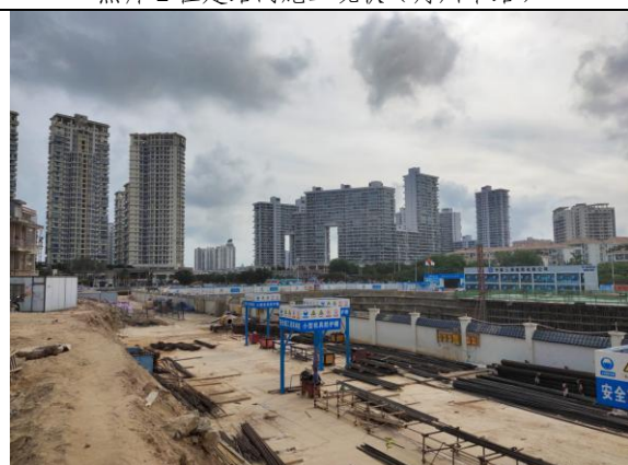
照片 4 在建保利国际广场项目
