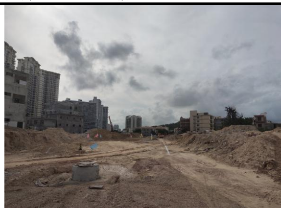
照片 2 在建路网施工现状（月川中路）
