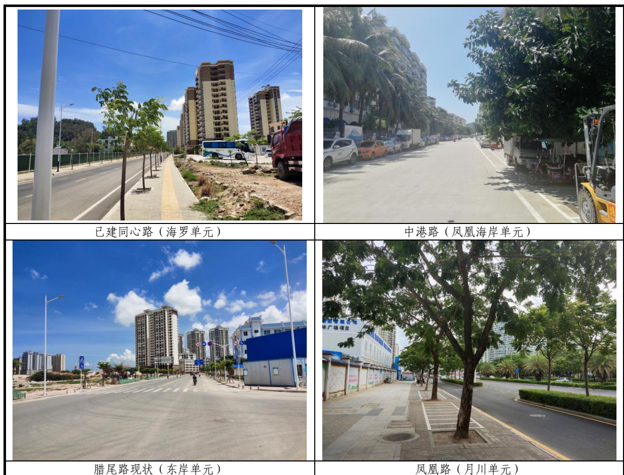
图 2-14 项目建设区现状市政道路
