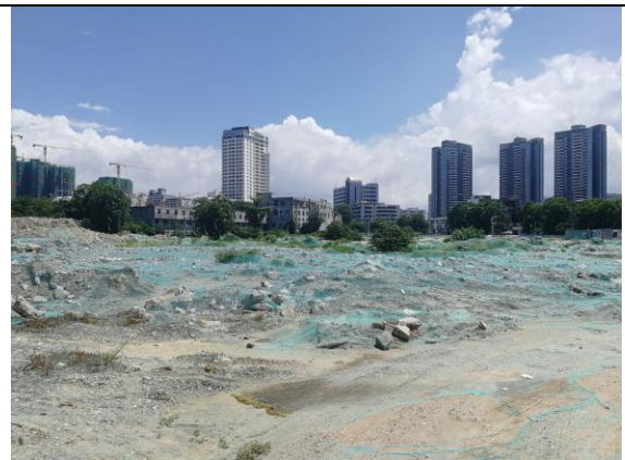
照片 8 港务局码头现状
