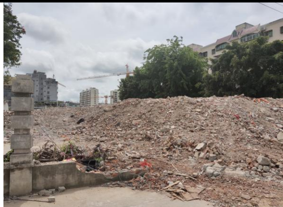
照片 2 拆迁产生的建筑垃圾一
