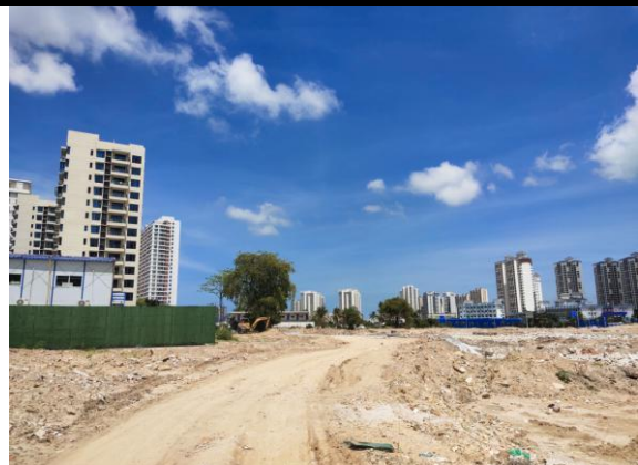
照片 1 拆除后的现状地面
