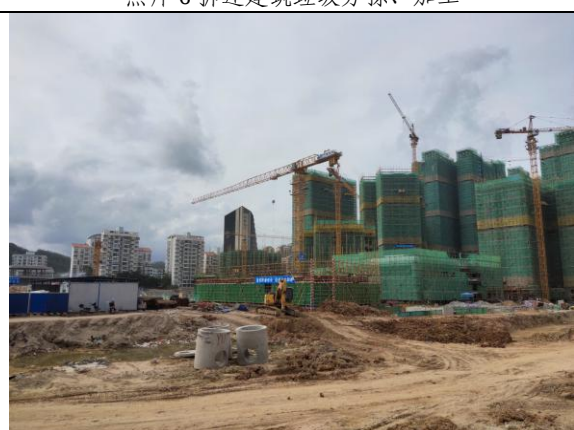
照片 8 周边在建安置区
